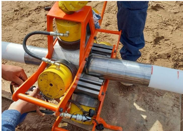
**Fig. 23** – Prensado de la cañería.
