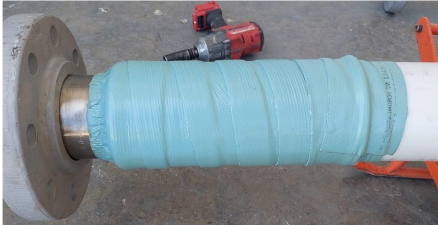
Fig. 28 –cinta STOPAQ anticorrosiva.
