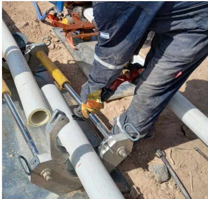
Fig. 20 – Cortado de la cañería antes de inserción.
