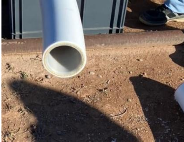
Fig. 17 – Vista del extremo de la cañería con un corte apropiado.
