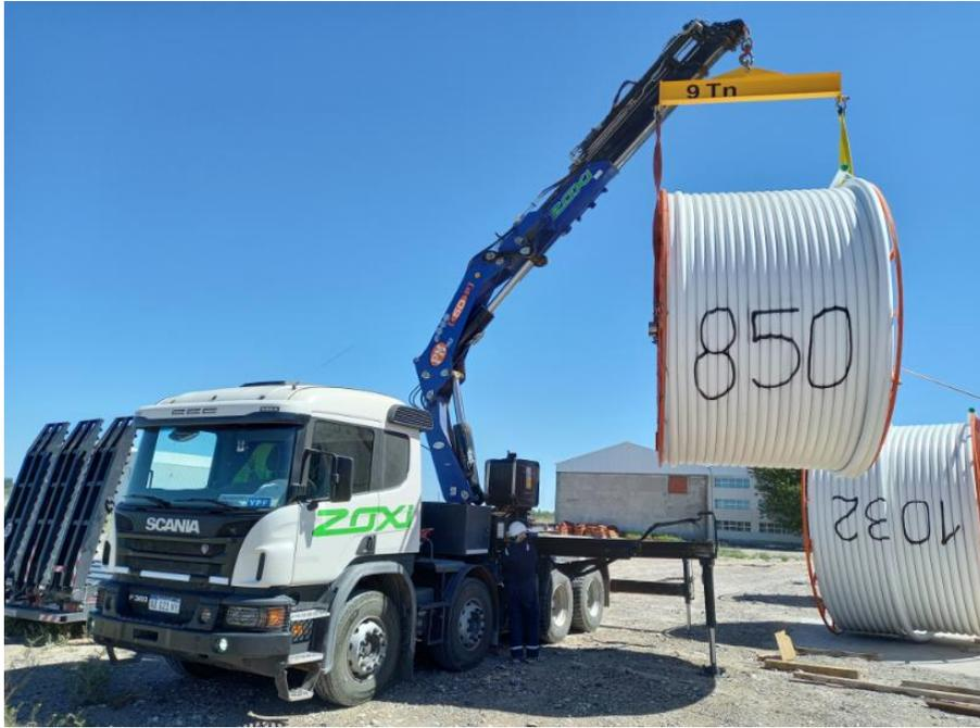
**Fig. 10** Carretel izado con percha de izaje.
