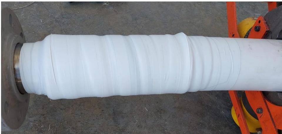
**Fig. 30** – cinta de PVC sobre protección mecánica.
