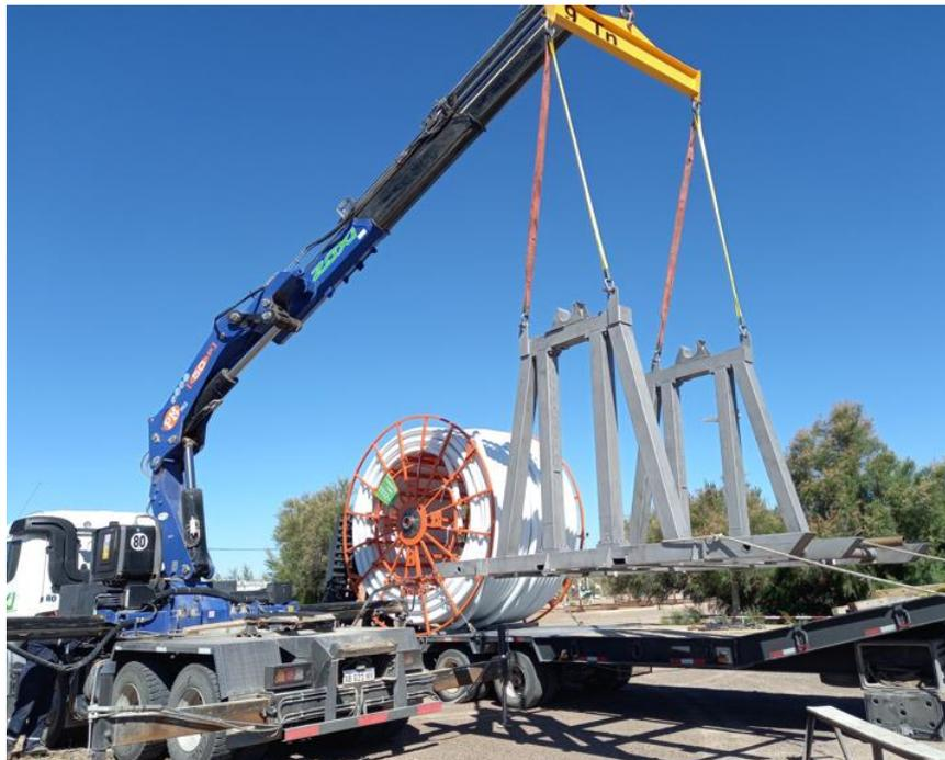
**Fig. 13** – Descarga del porta carretel desde el camión.
