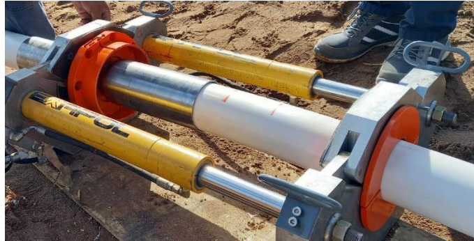
Fig. 22 – Marcas de inserción en la cañería.
