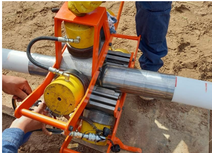
Fig. 23 – Prensado de la cañería.
