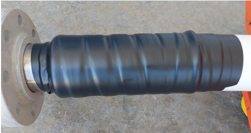
Fig. 29 –cinta STOPAQ de protección mecánica.
