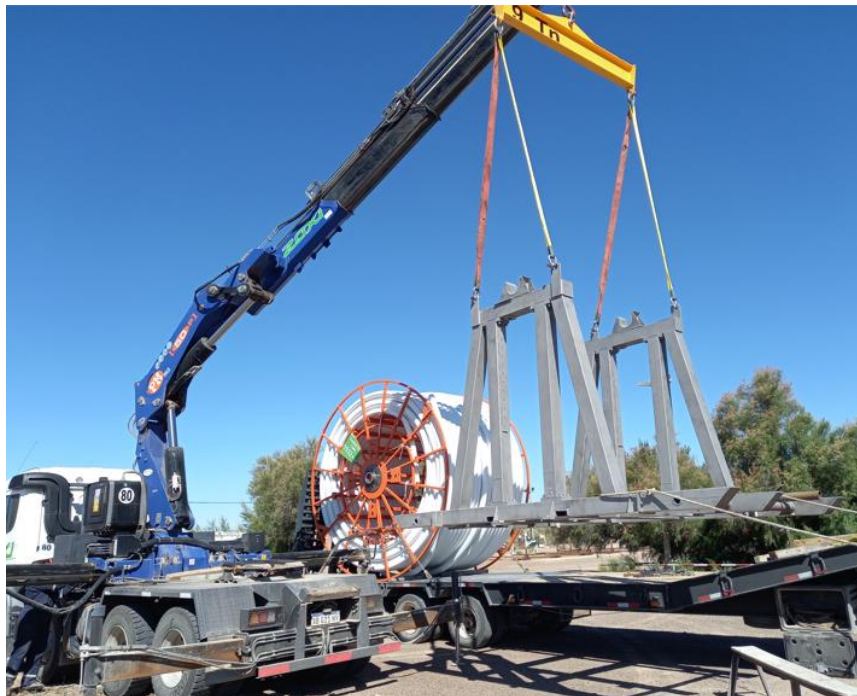
Fig. 13 – Descarga del porta carretel desde el camión.
