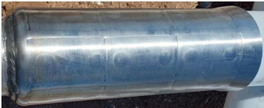
**Fig. 27** – prensado finalizado
