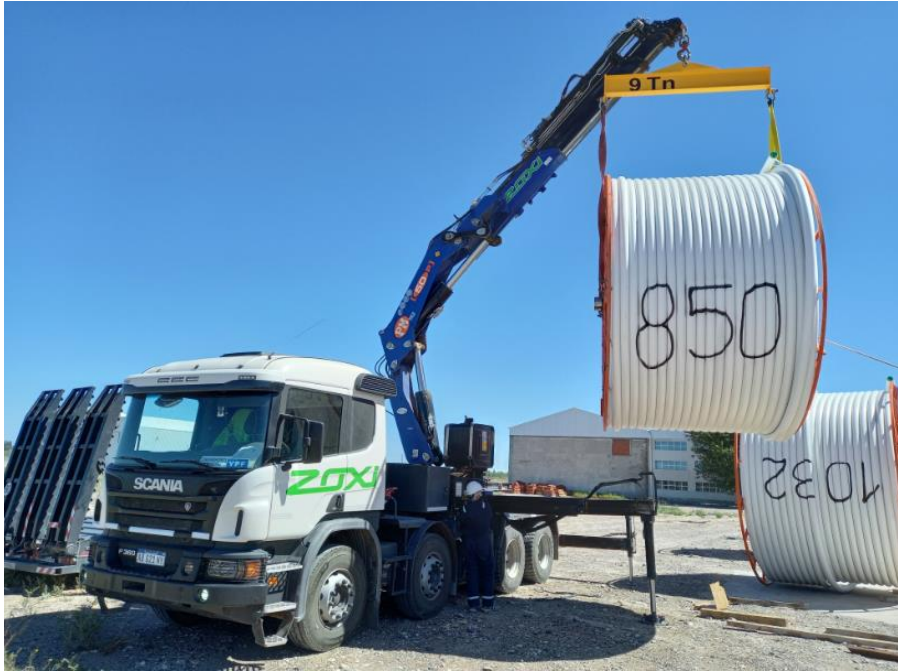
Fig. 10 Carretel izado con percha de izaje.
