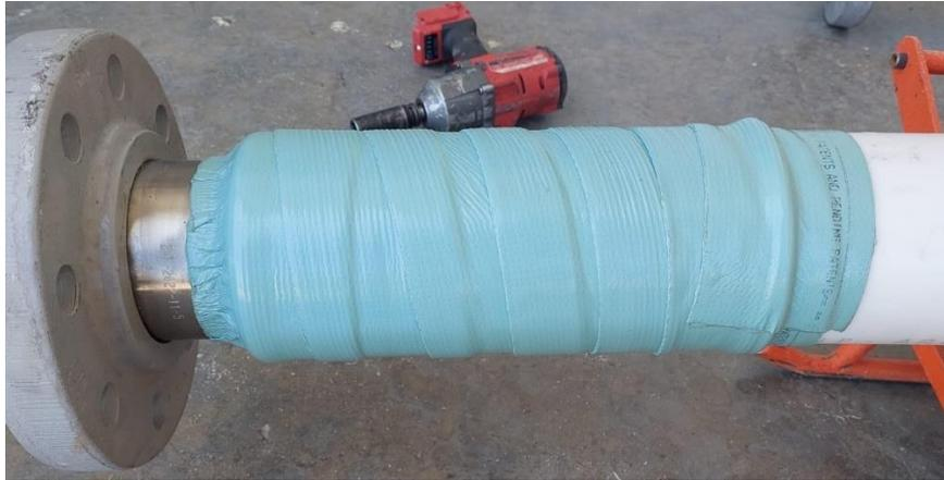
**Fig. 28** –cinta STOPAQ anticorrosiva.
